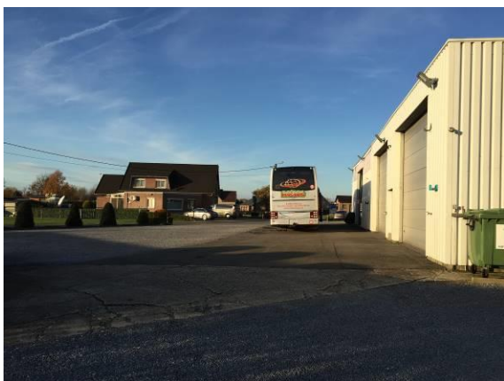
Foto 4 Zicht op de circulatieruimte/parking voor de gebouwen
