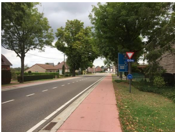
Foto 1 Steenweg Borgloon – kijkend richting centrum Wellen
