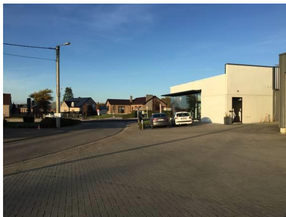
Foto 2 Zicht op het kantoorvolume vanaf de Herstalstraat
