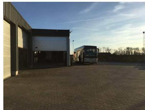
Foto 3 Zicht op de circulatieruimte/parking voor de gebouwen
