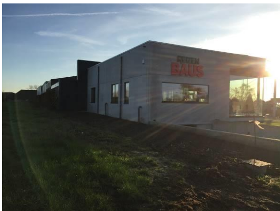
Zicht op het kantoorvolume vanaf de Zonneveldweg
