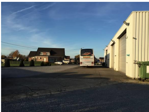
Zicht op de circulatieruimte/parking voor de gebouwen
