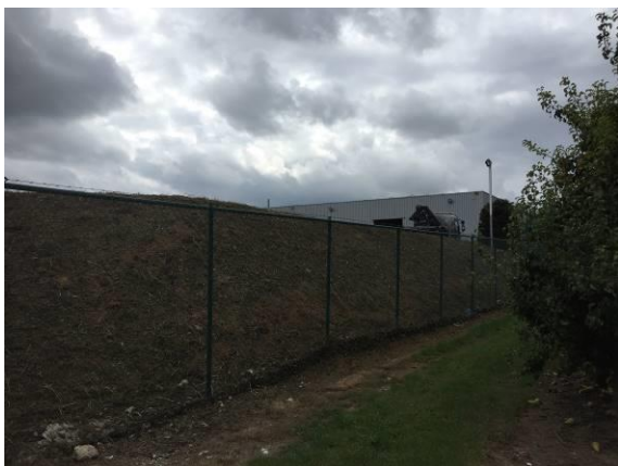
Zicht op de noordelijke rand van de bedrijfssite vanaf de achterliggende buurtweg
