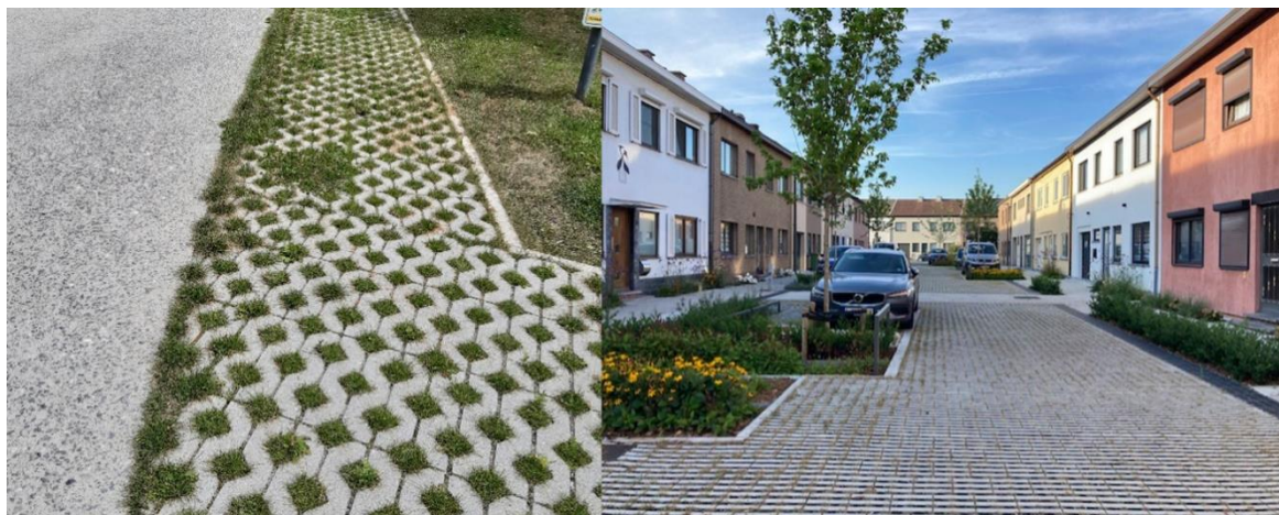
Figuur 15: Vlnr: (1) Versmald voet-fietspad met uitwijkmogelijkheid over waterdoorlatende verharding (Overijse). © Aquafin; (2) Tuinstraat met zowel rijweg als parkeervakken aangelegd in halfverharding (Aziëlaan, Wilrijk). © Aquafin.
