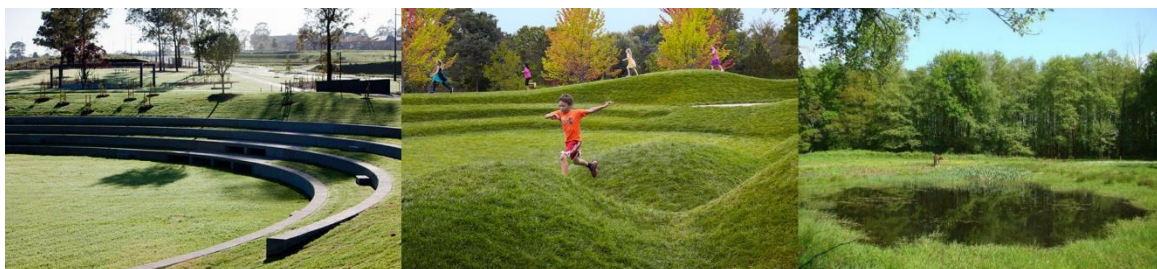
Figuur 24. Voorbeelden van bovenlokale buffers. Bovenlokale buffers kunnen meerdere functies combineren. Links en midden wordt de bufferfunctie gecombineerd met een recreatieve functie, waar de foto rechts infiltratie en buffering combineert in een wadi.
