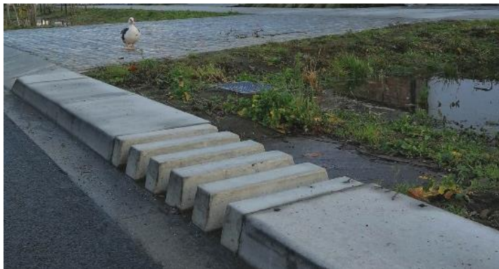
Figuur 21. Een voorbeeld van een boordsteen met spleten zoals toegepast in de Fortstraat in Mortsel (Bron: dbpubliekeruimte.info).
