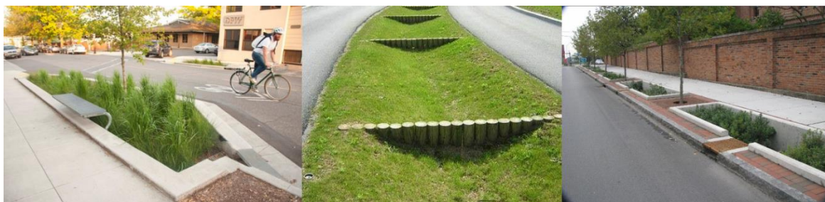
Figuur 25. Voorbeelden van lokale buffers/infiltratievoorzieningen. Zo kunnen reeds bestaande verkeerselementen ook een waterfunctie vervullen en voorzien in infiltratie en buffering op straatniveau (Bron links: Clay street door Green Works).
